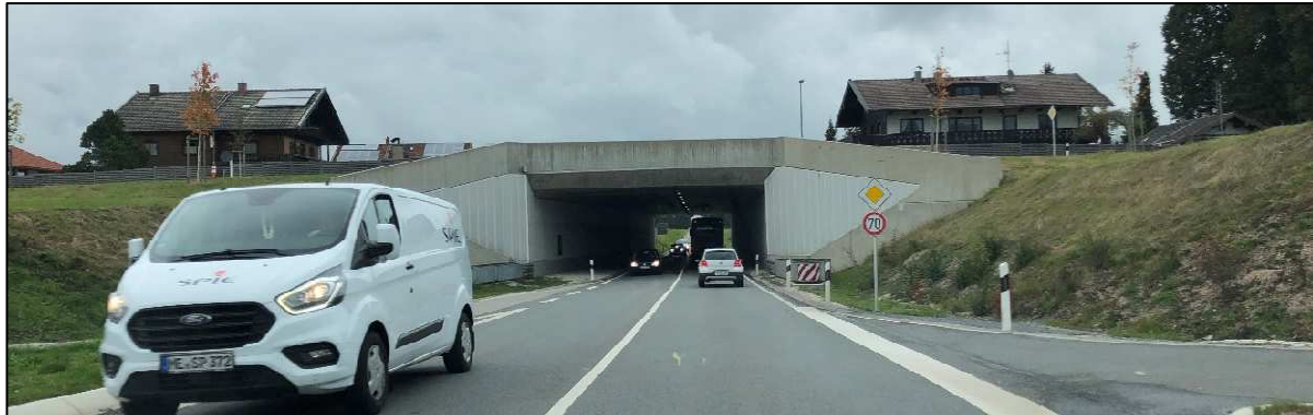
Abbildung 7 Blick nach Norden auf die südliche Einfahrt in den Tunnel (d)
