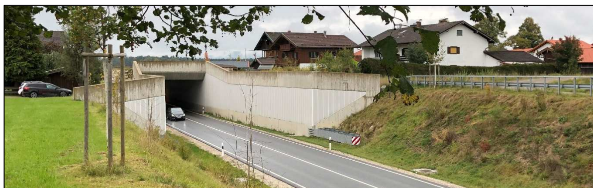
Abbildung 6 B 318, Stützwände an der nördlichen Einfahrt in den Tunnel (d)
