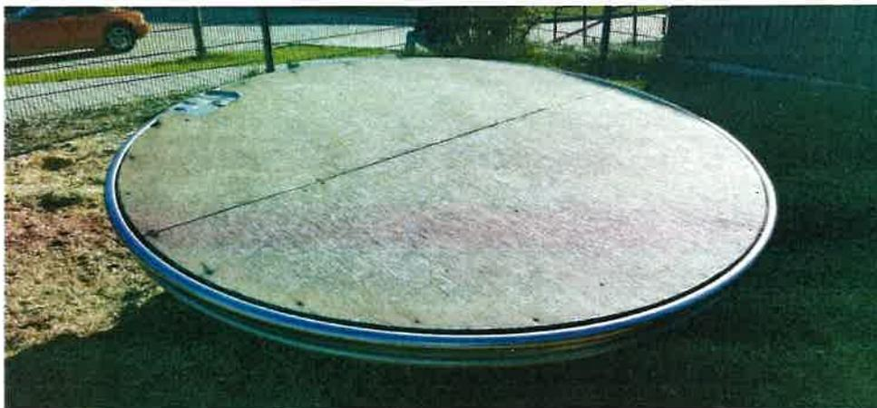
Nachdem das Spielgerät bereits ganzjährig der Witterung ausgesetzt ist, ist die bestehende obere Siebdruckplatte mittlerweile an einer Stelle durchgefault und durch das Kindergartenpersonal provisorisch mit Epoxidharz repariert worden.
