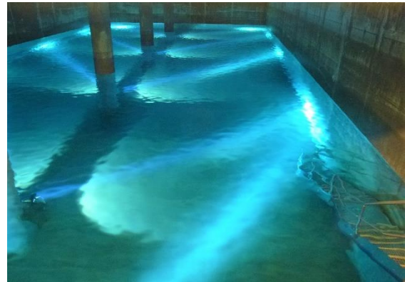
Quelle: Hochbehälter P1; fotografiert von Norbert Strauß, Dozent der vhs Oberland
